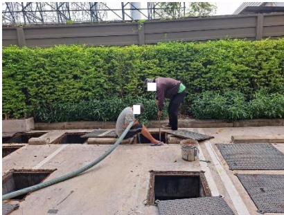
ภาพที่ 2-13 การตัดไขมันจากระบบบำบัดน้ำเสีย
